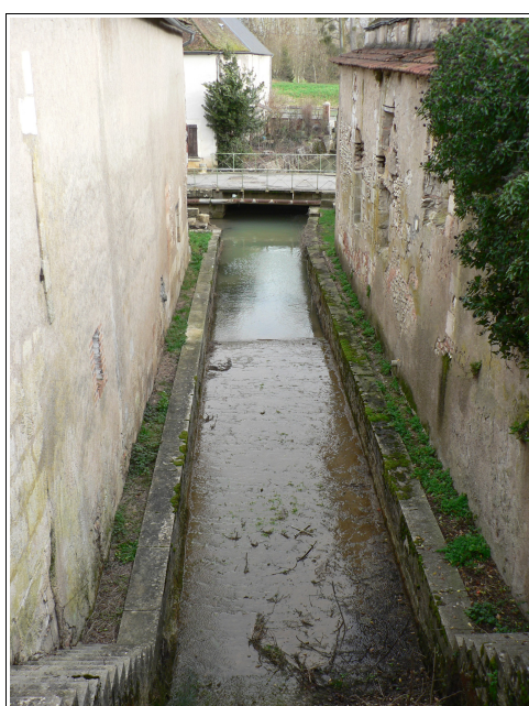
Figure n°9 : Exemples d'ouvrages hydrauliques pouvant accentuer le débordement de l'eau
